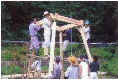
住民による東屋の建設風景
