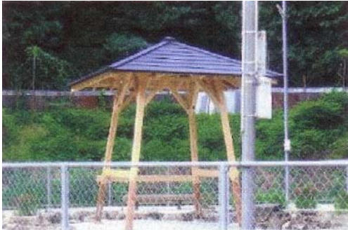
完成した東屋
